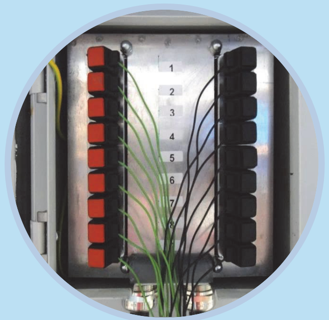
Prüfverdrahtung mit Sicherheits-Schnelldruckklemmen Test leads with safety quick-release terminals
